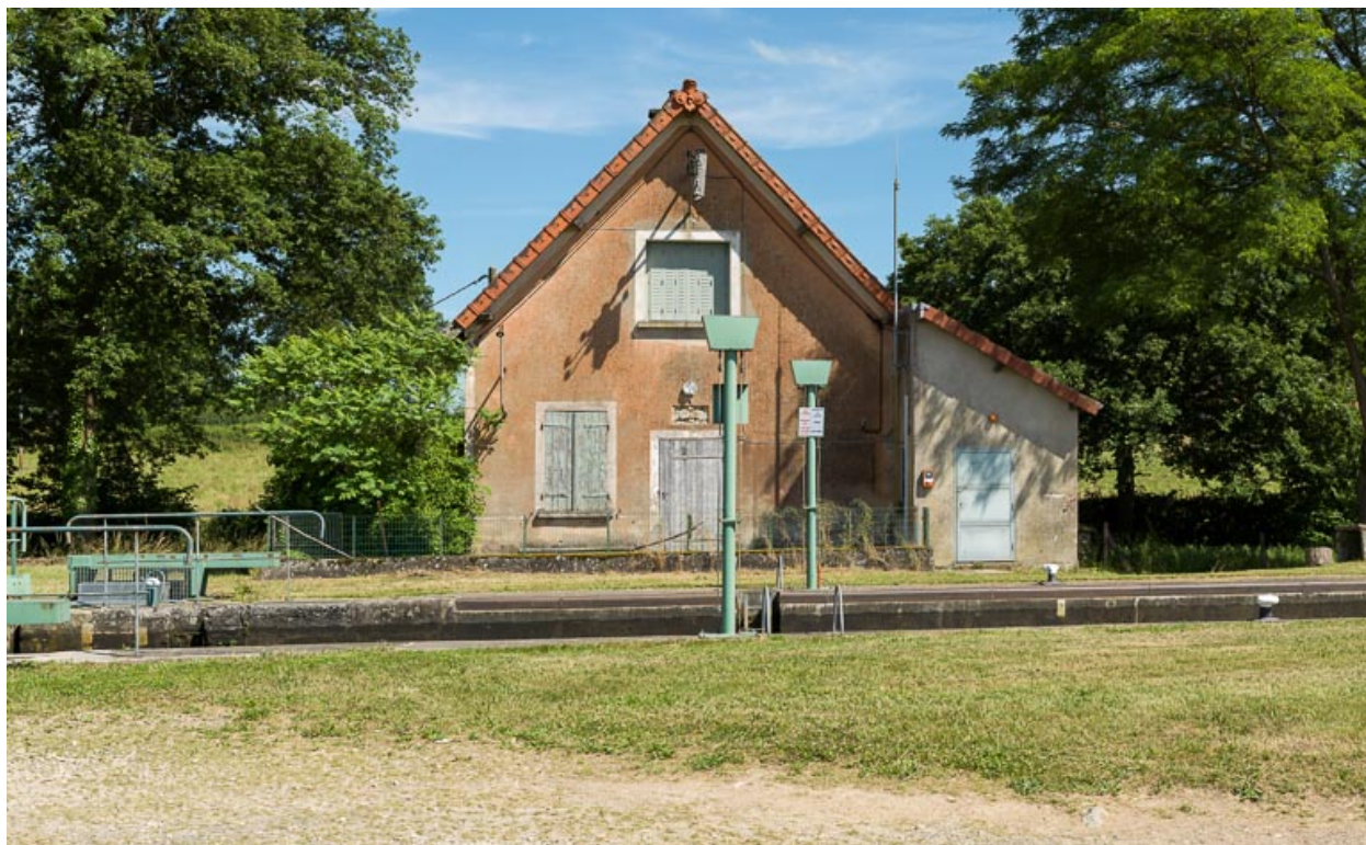
Vue d'ensemble avec la maison éclésièr de face.
