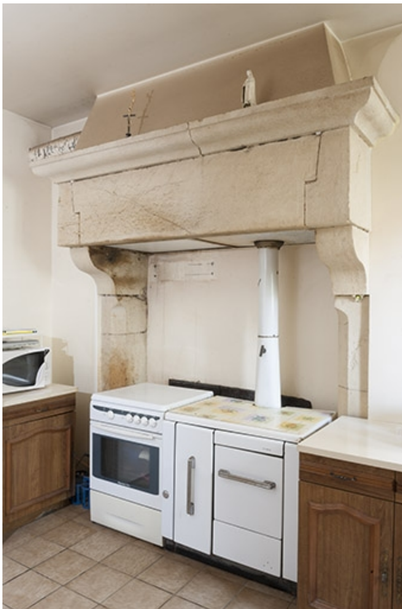
Cuisine : vue générale de la cheminée.
