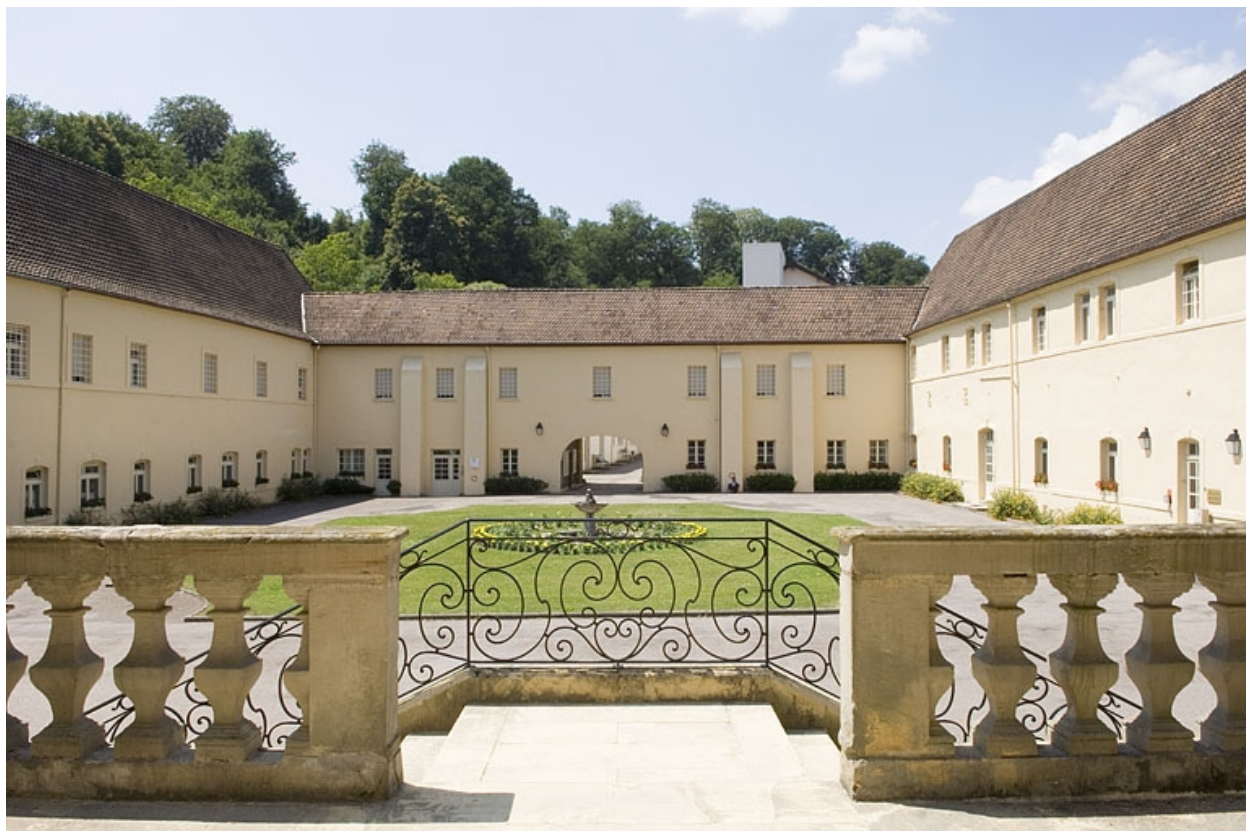
Bâtiments sur cour.
