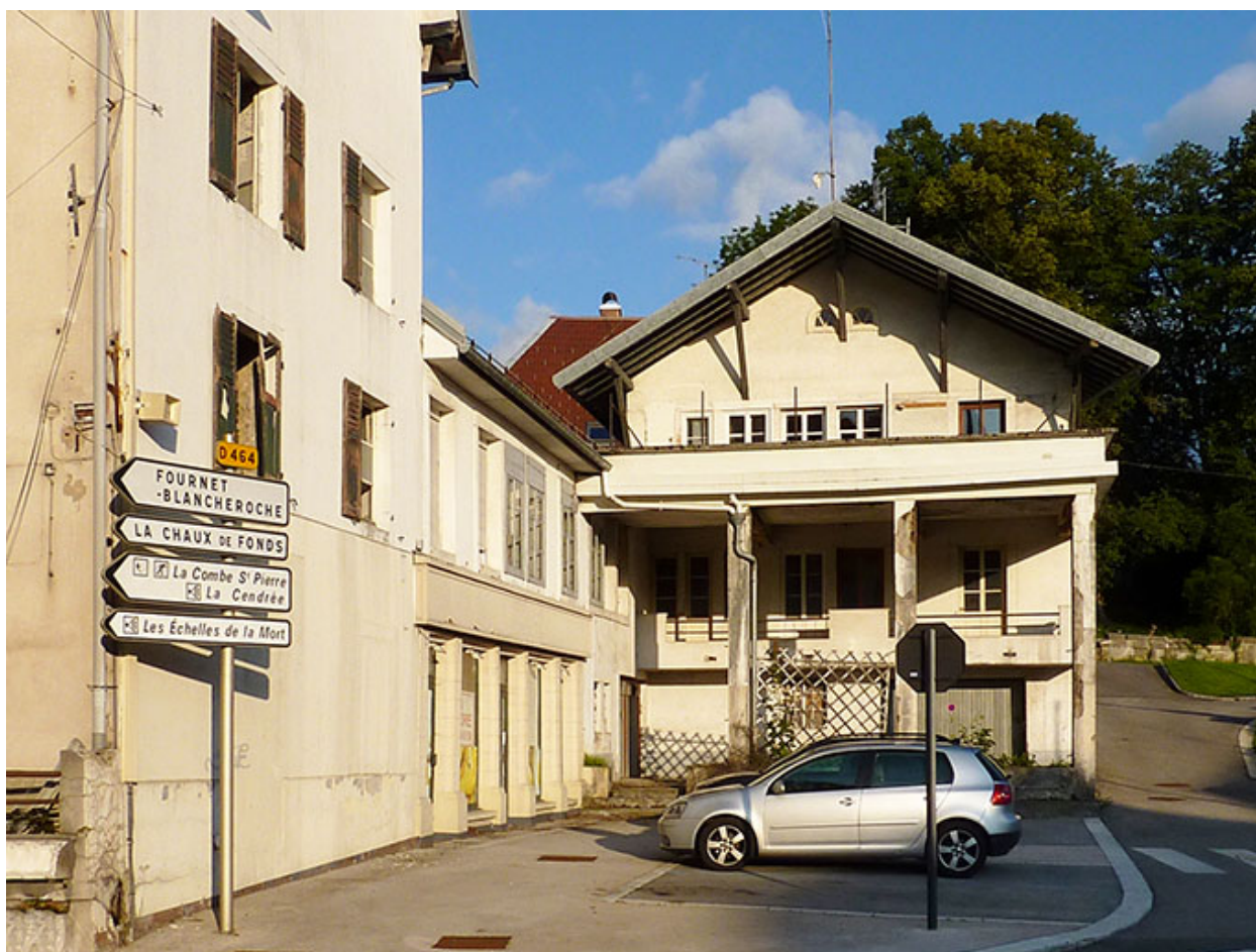
Logement surmontant le garage, 17 juillet 2012.
