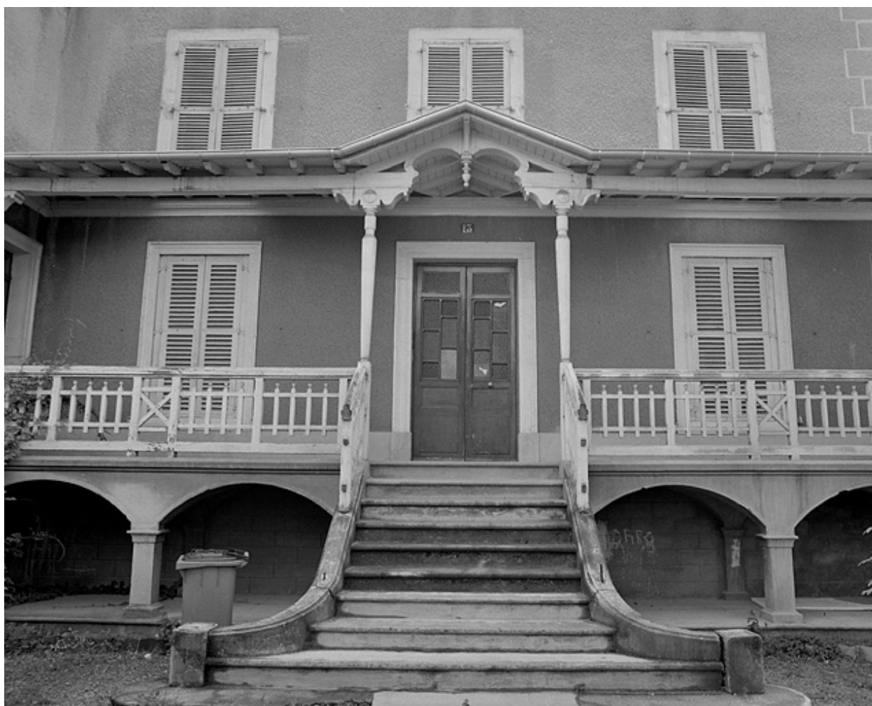
Façade antérieure, perron et galerie ouverte.
