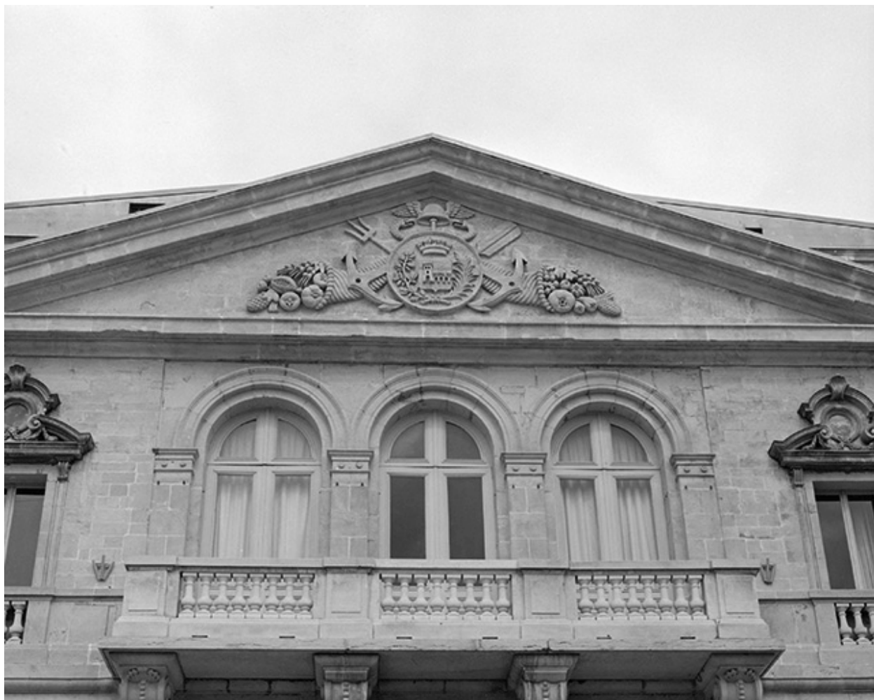
Façade antérieure. Corps central, fenêtre et fronton.
