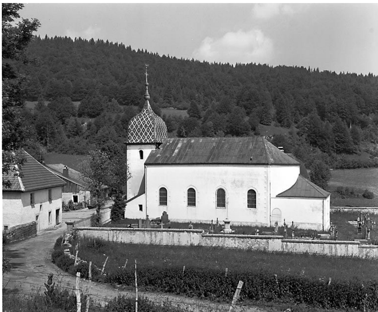
Façade latérale droite.
