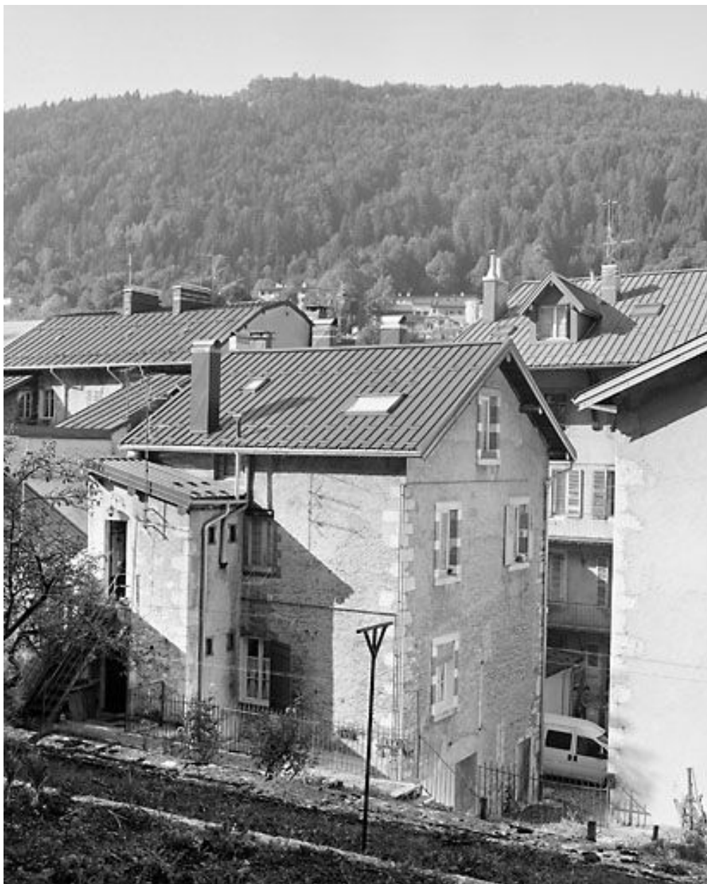
Bâtiment sud, vu du jardin.
