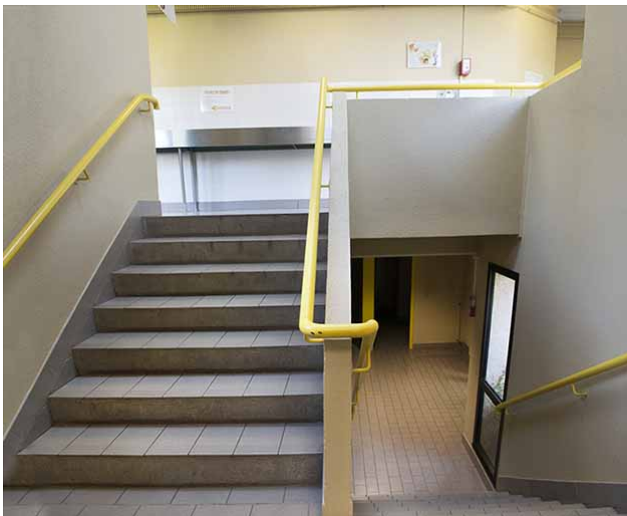
Escalier dans la cantine.
