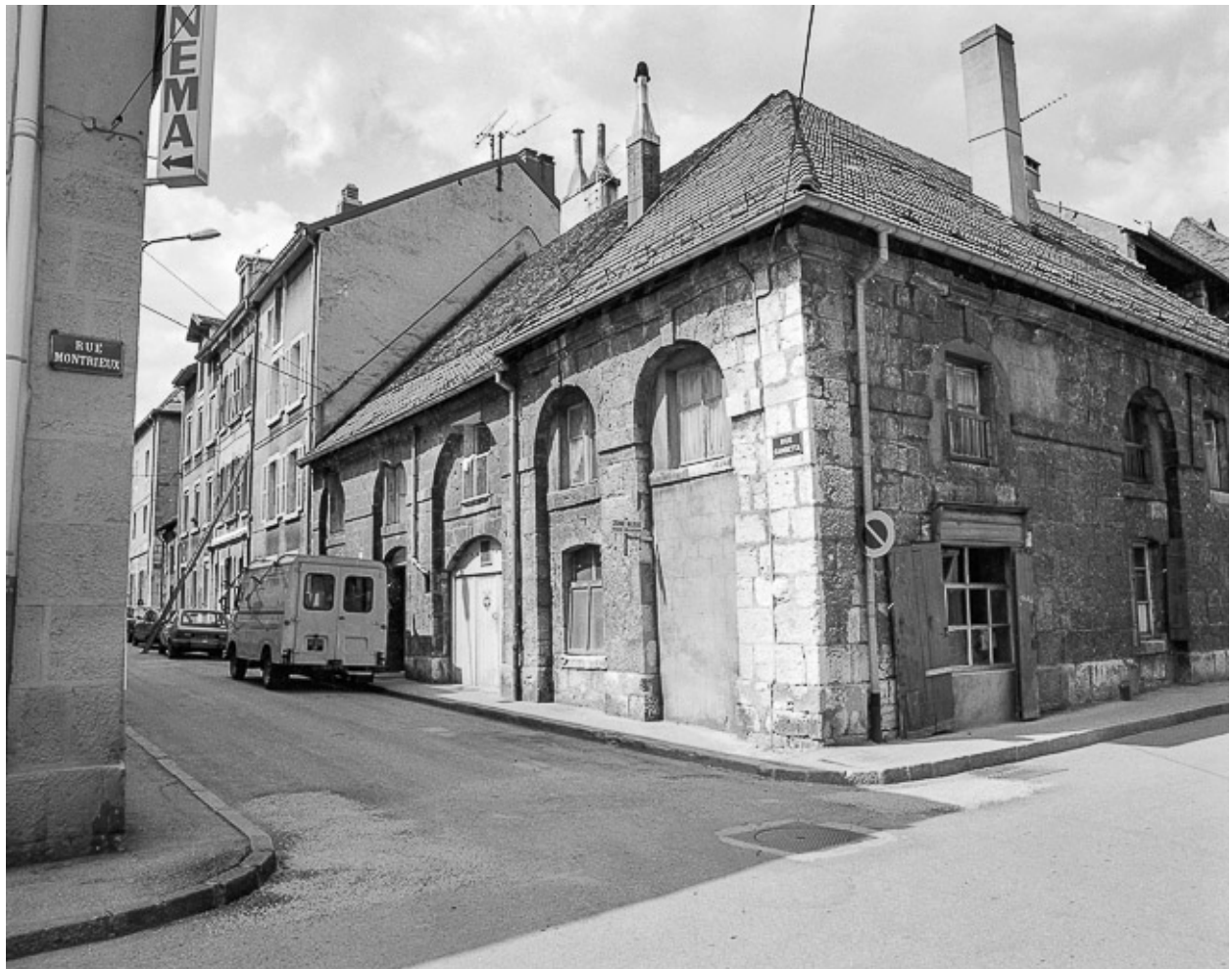
Façade sur la rue Montrieux, de trois quarts droit.
