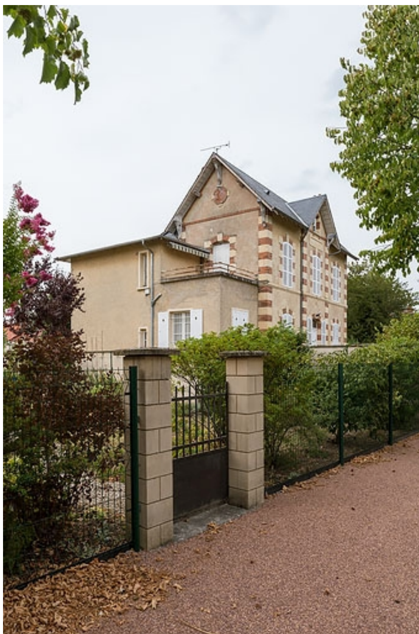
Vue de trois-quarts, depuis l'avenue du Casino.
