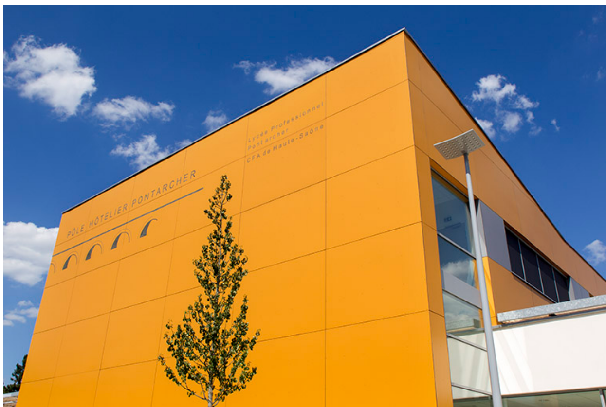
Détail du pignon d'entrée-sud.
