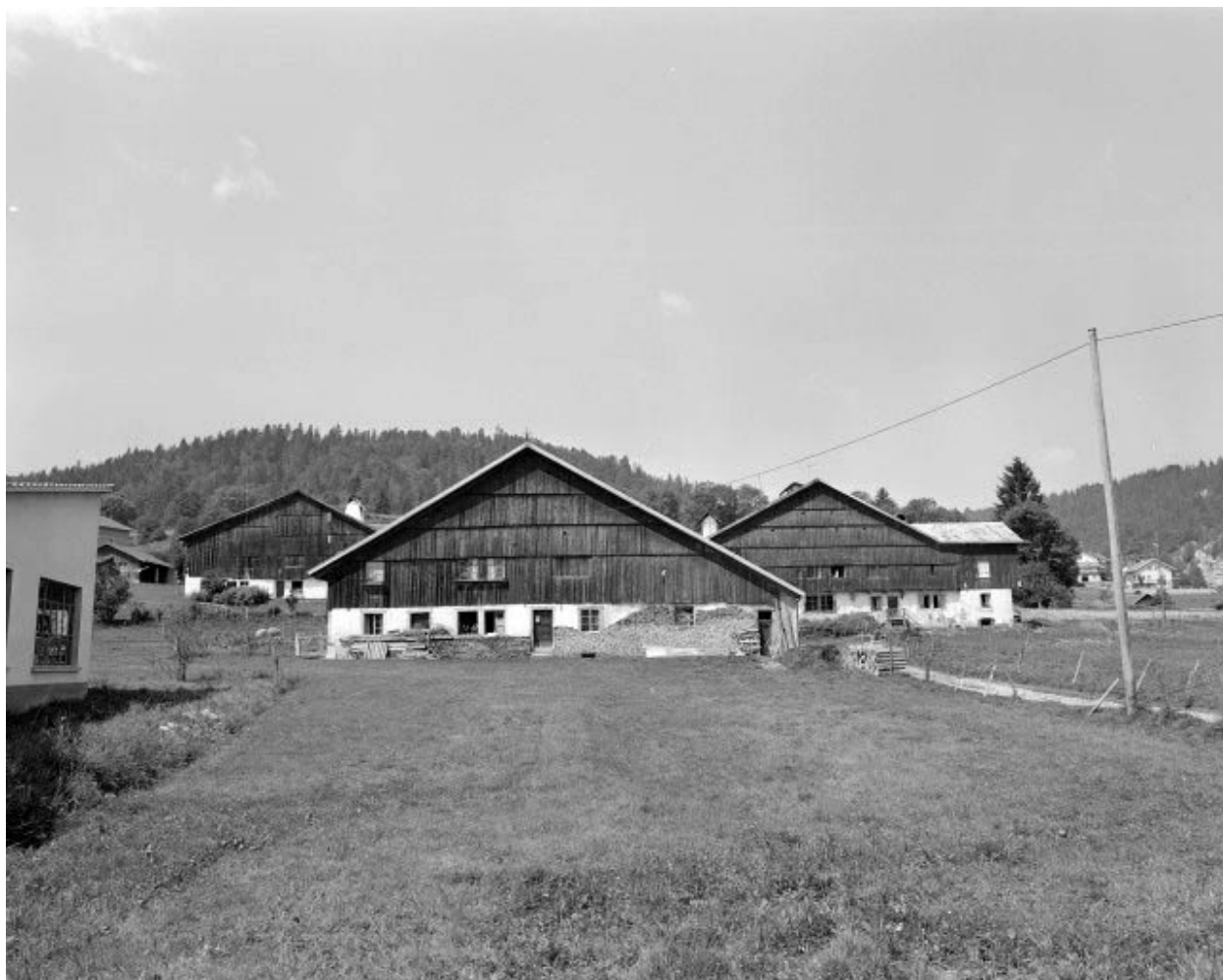
Grand'Combe-Châteleu : ferme située au lieu-dit Les Cordiers.
