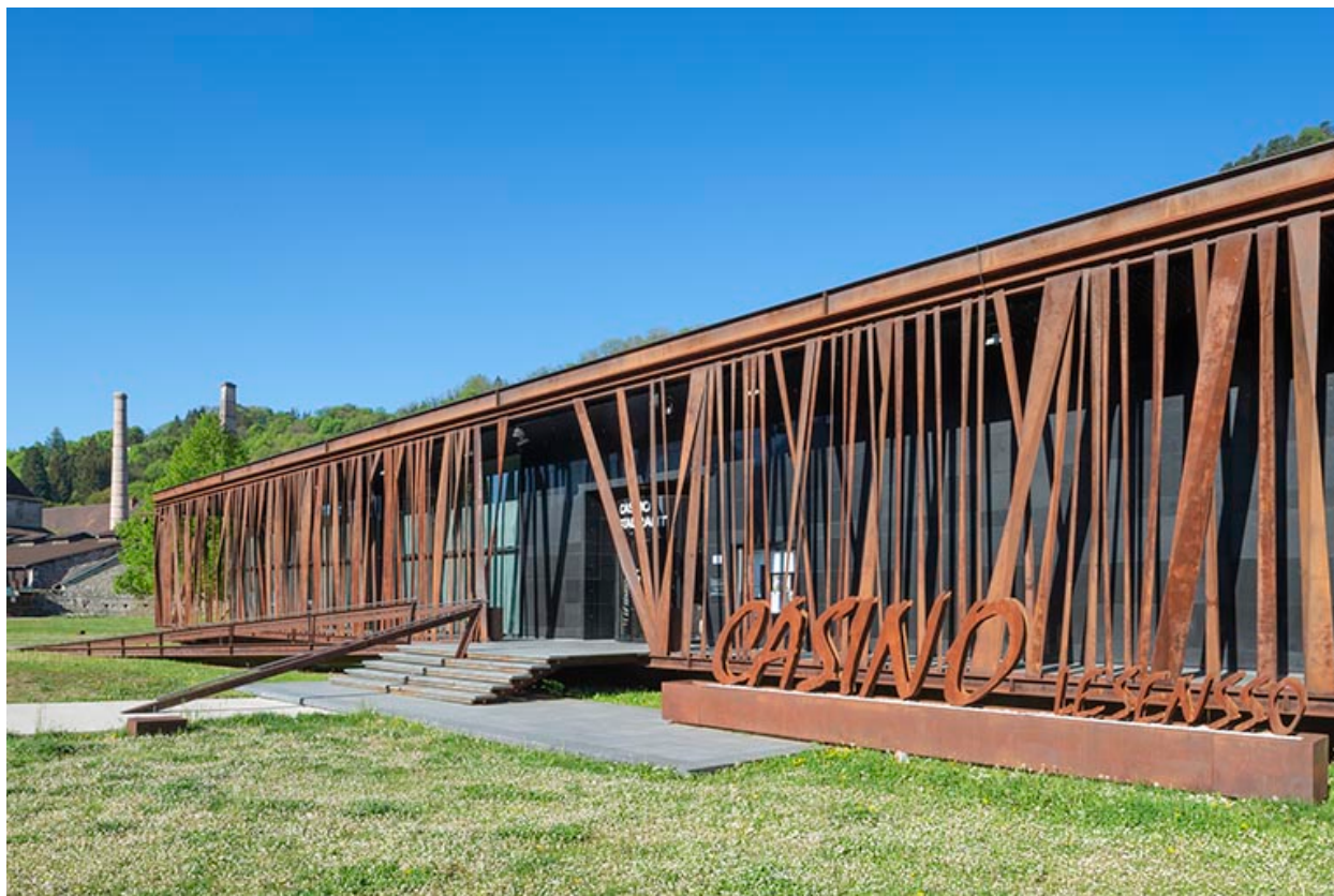
Vue depuis le nord-est.
