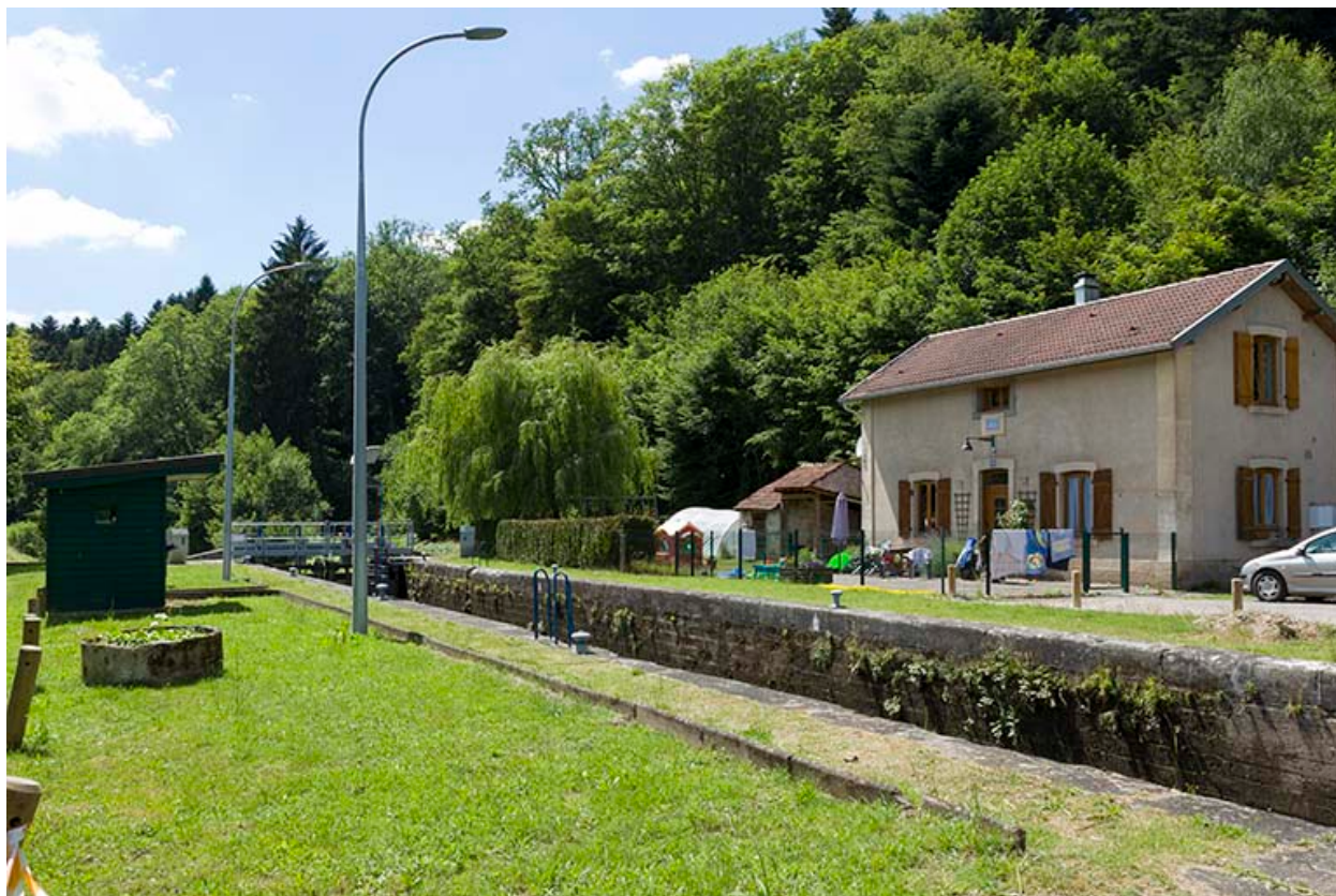
Le site d'écluse.
