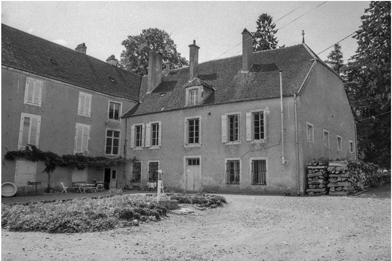
Vue de l'habitation depuis la cour.
