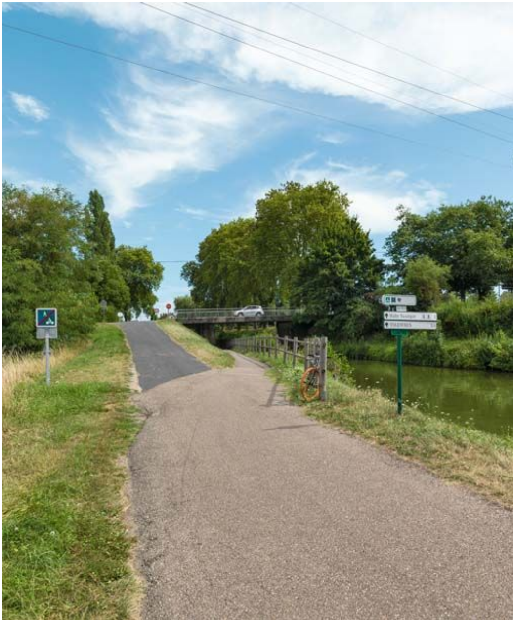
Vue d'ensemble du pont.
