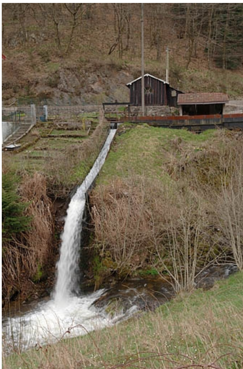
Le déversoir du bassin de retenue.
