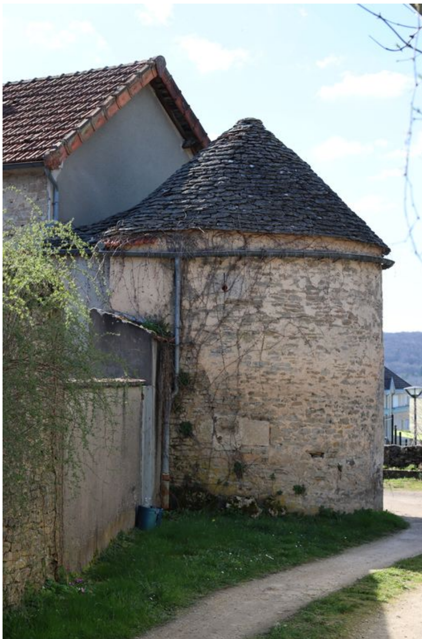
Vue de la tour depuis l'est.
