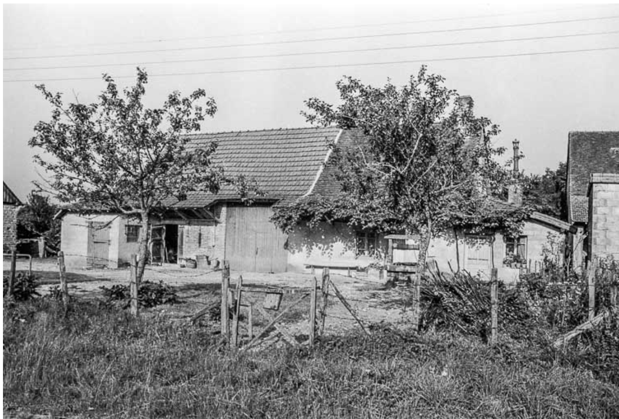
Ferme cadastrée 1956 A2 431 : façade antérieure.
