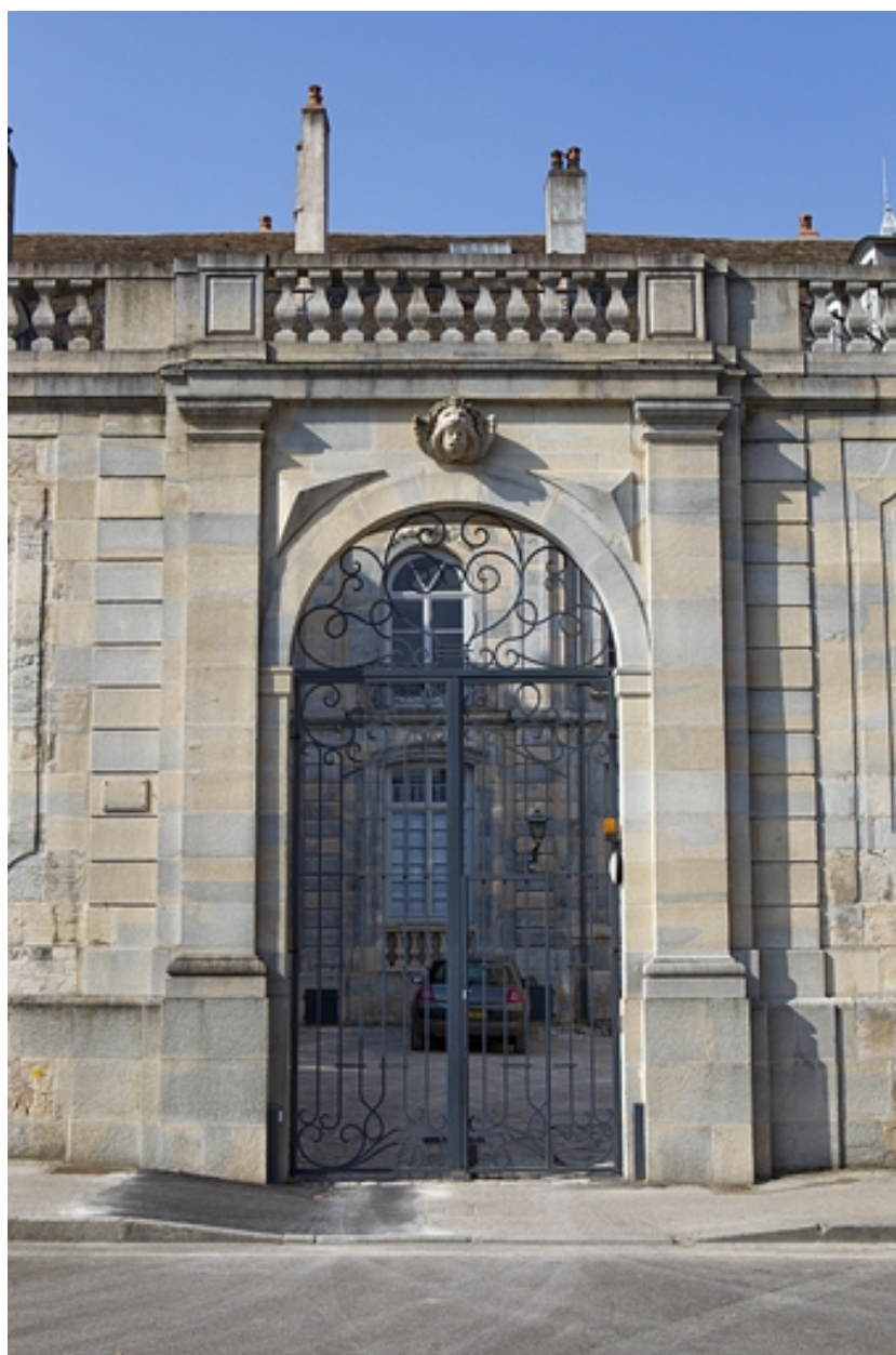
Vue d'ensemble du portail dans clôture.
