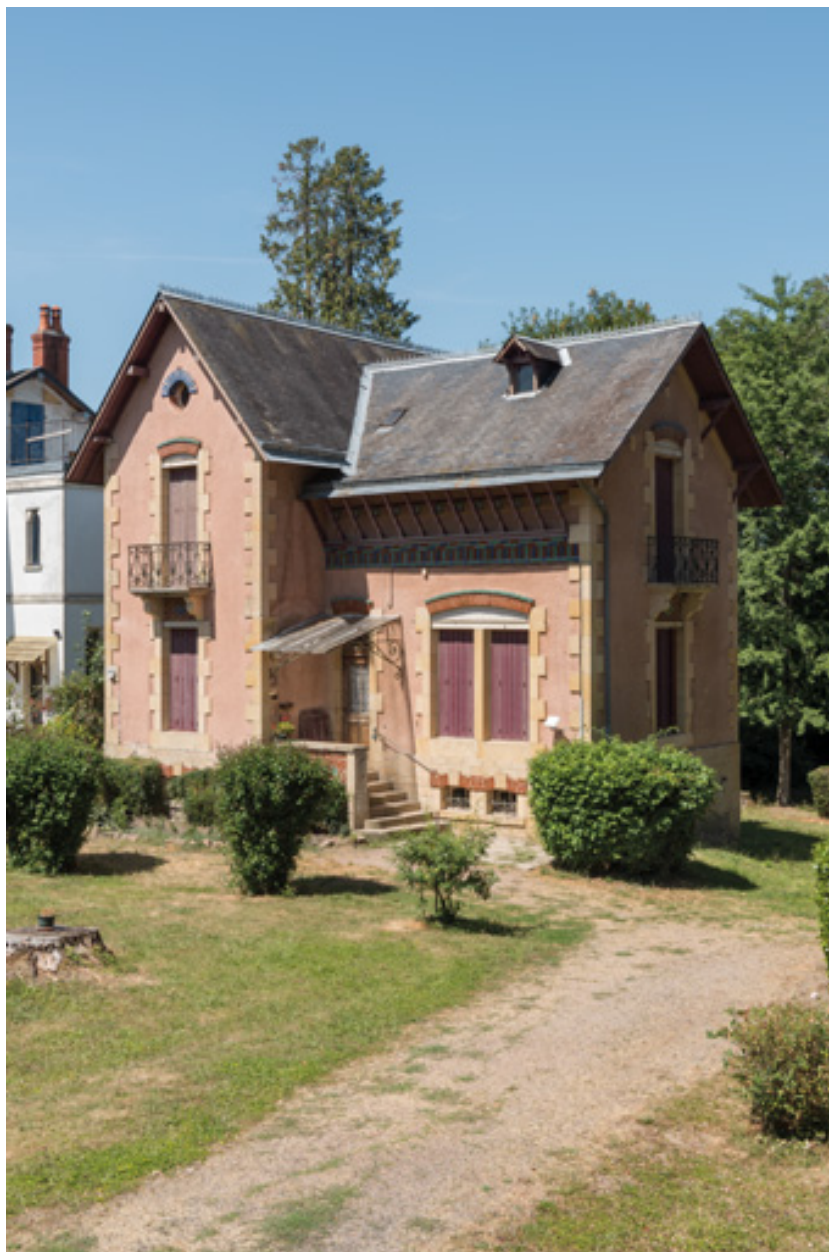
Façade sur l'avenue de Rémilly.
