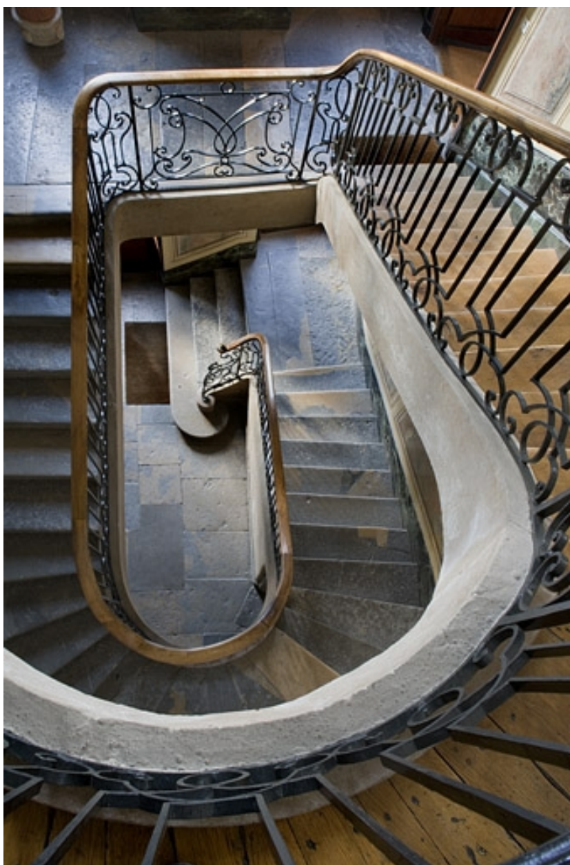
Escalier : vue plongeante.
