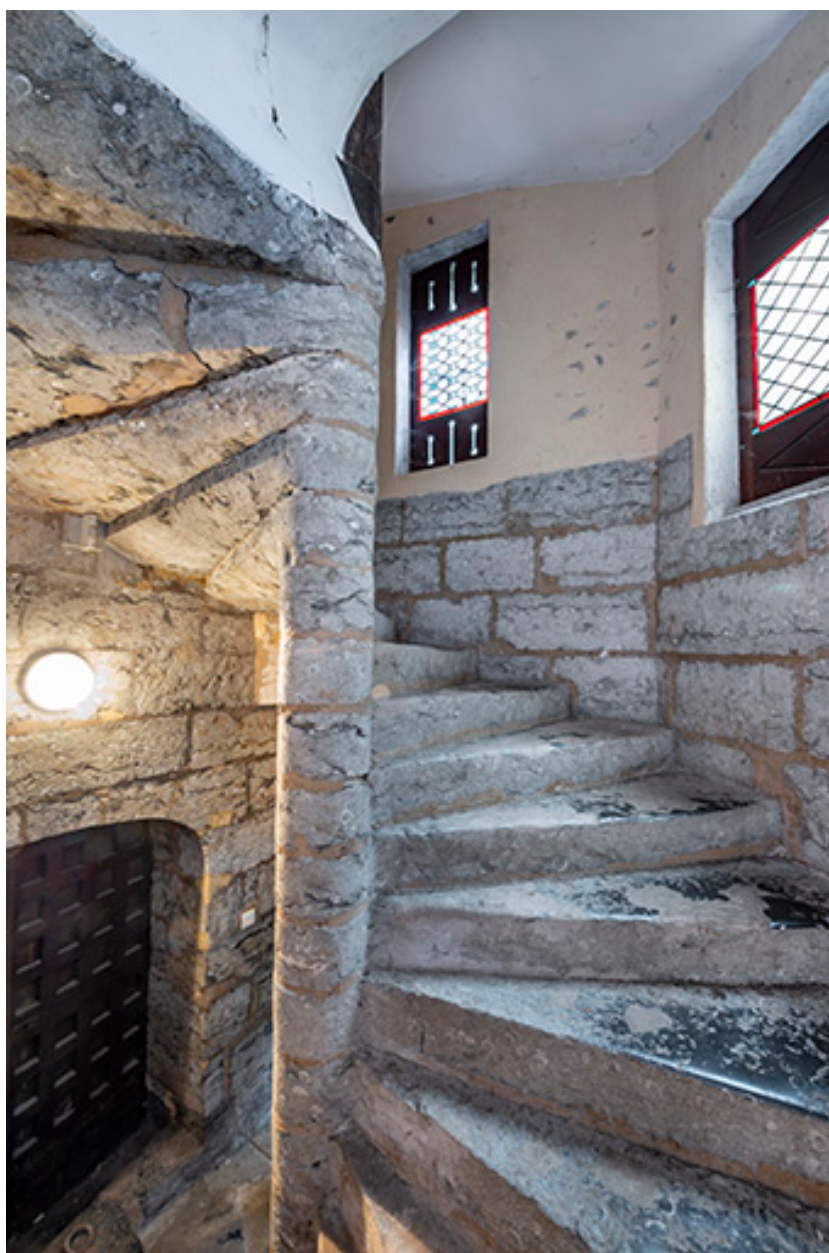
Escalier en vis : accès au premier étage.
