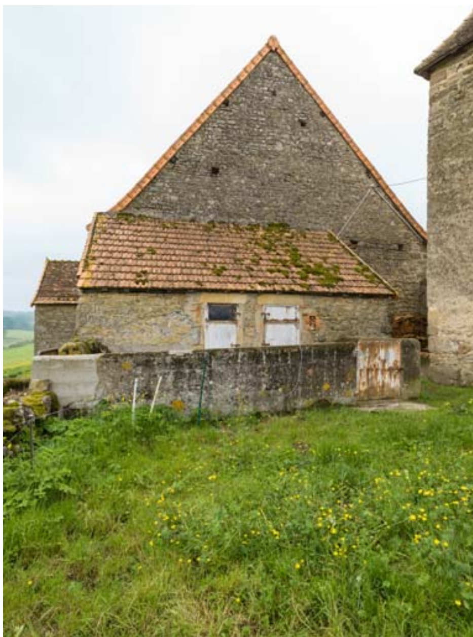
La soue adossée au pignon de l'étable.
