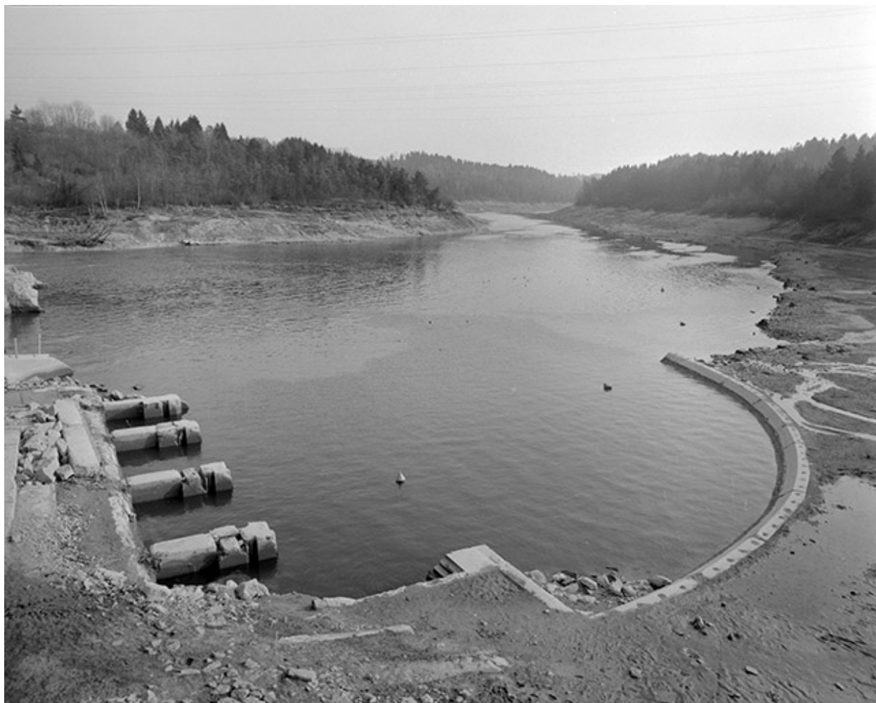
Fondations et bassin d'amortissement.
