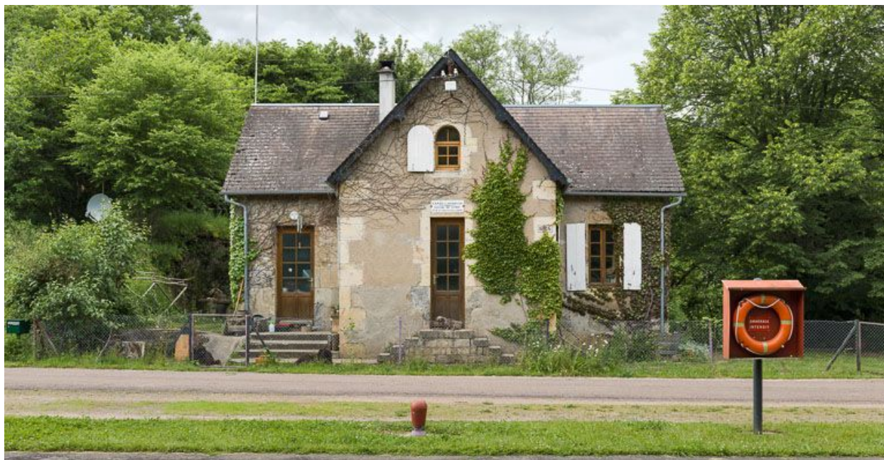
Vue de face de la maison éclusière.
