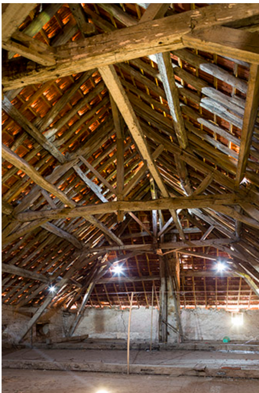
Vue intérieure de la charpente de toit.
