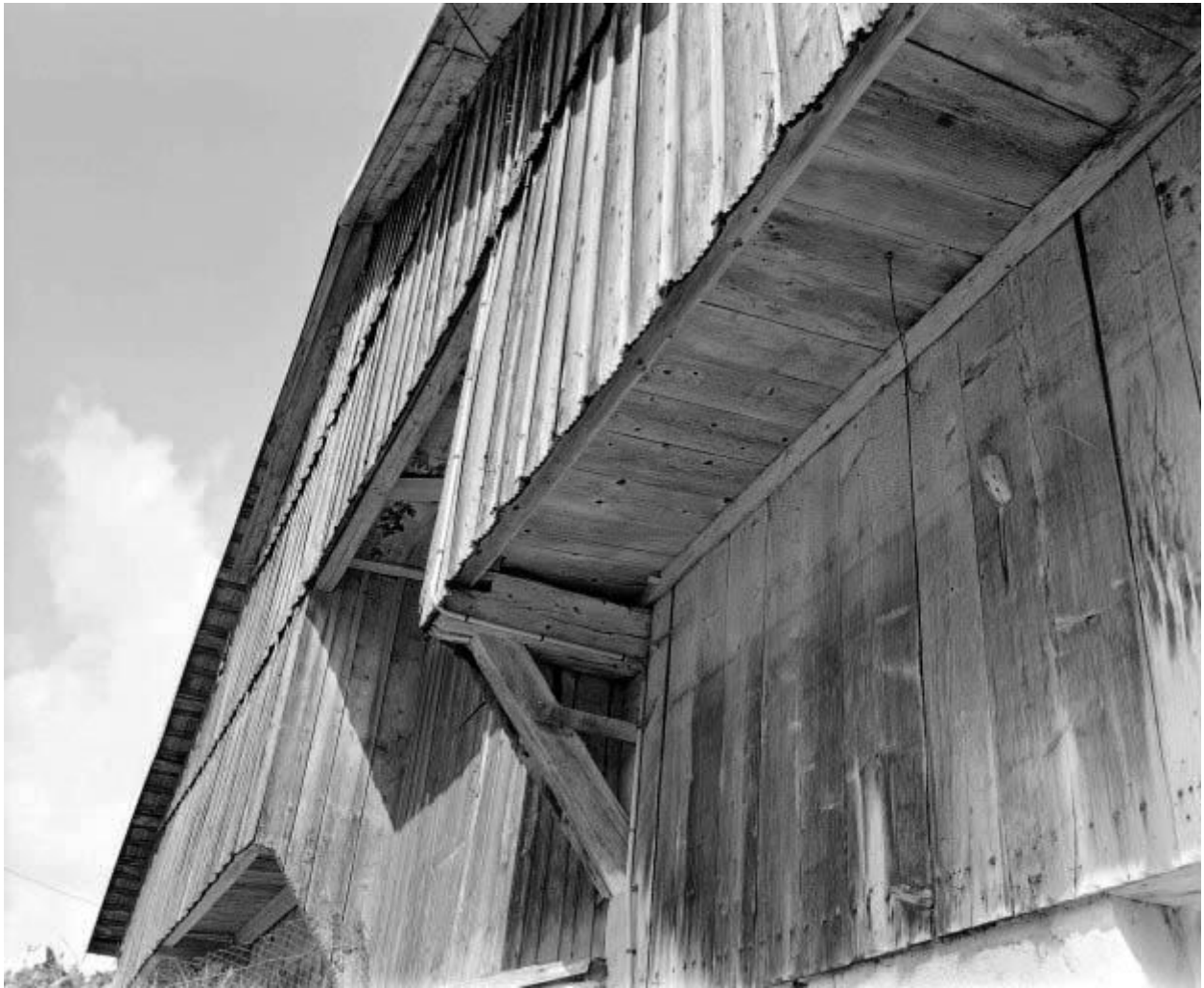
Détail : débord de la "lambrechure" sur le pignon antérieur.
