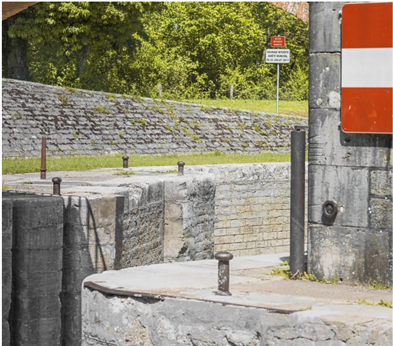
Détail des traces de halage et de la maçonnerie du sas.
