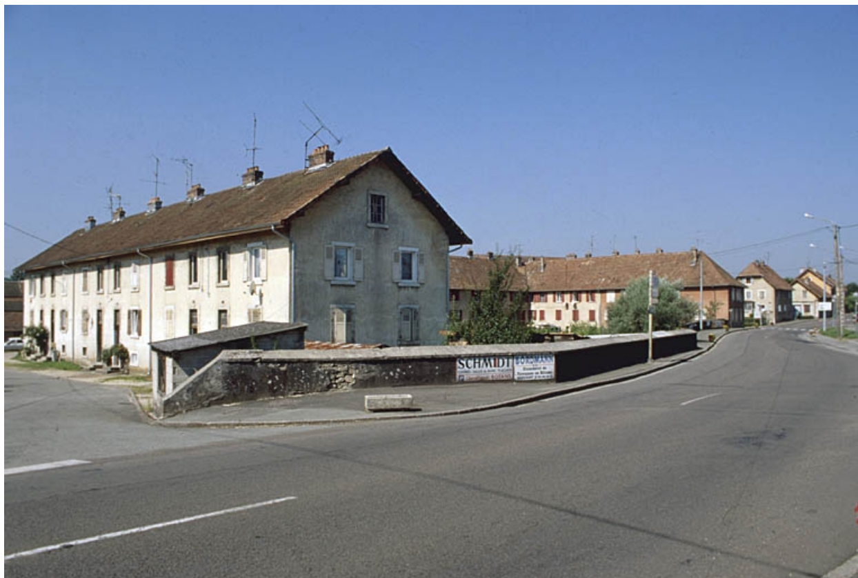
Logements ouvriers depuis l'est.
