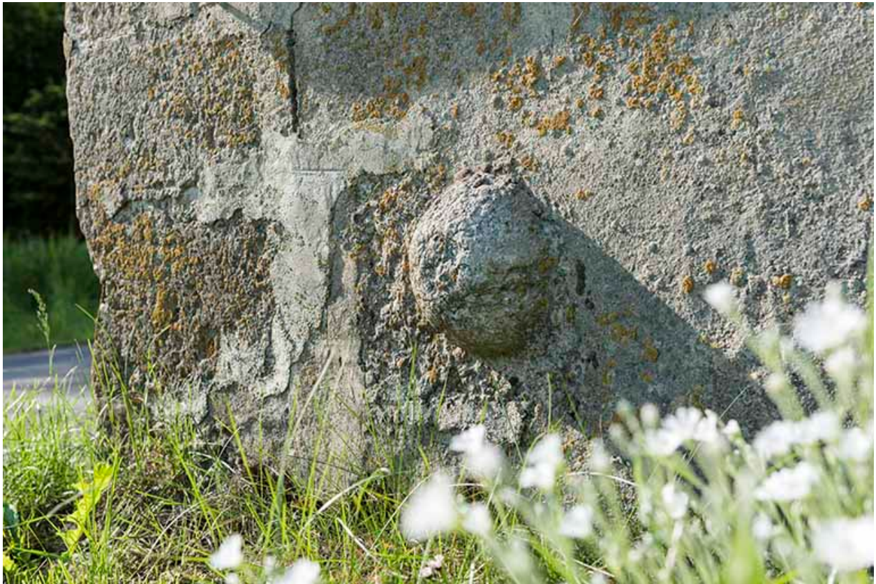
Façade nord : pierre avec relief hémisphérique.
