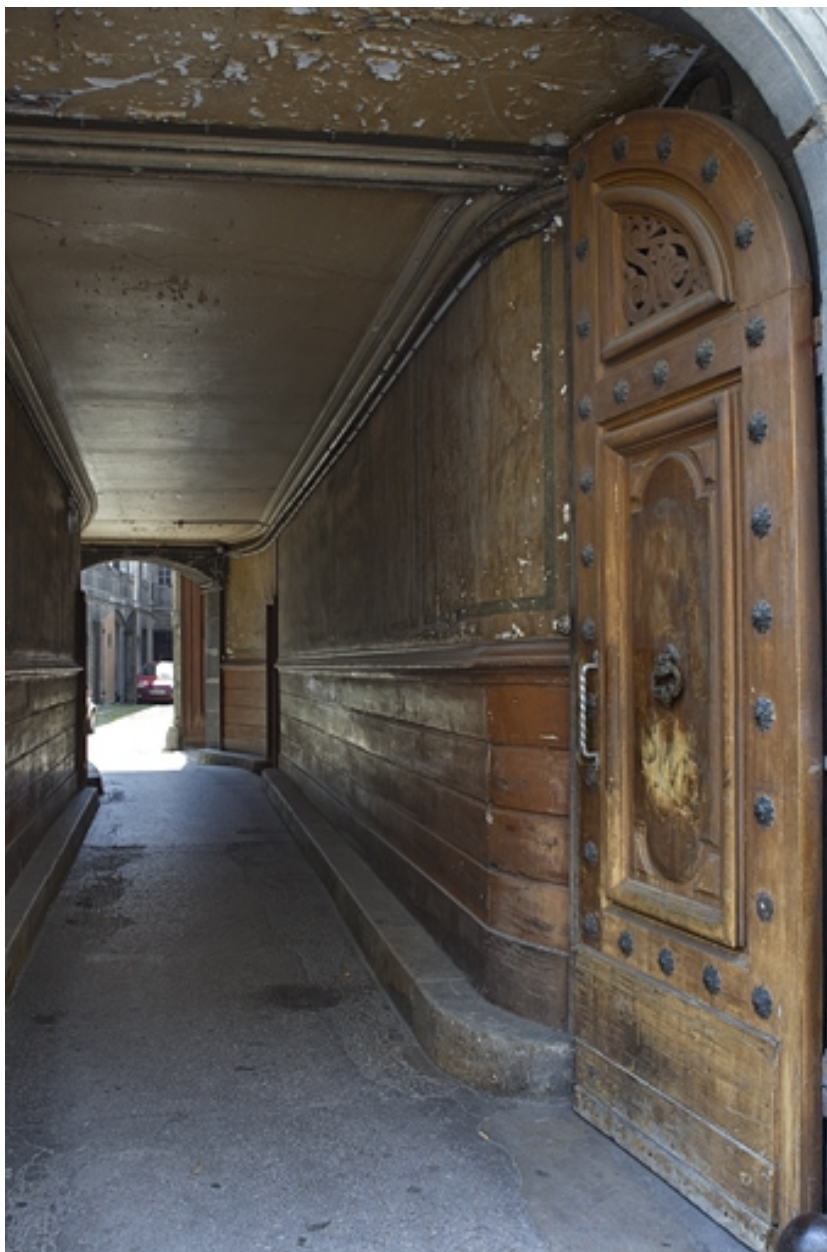
Vue d'ensemble du passage cocher depuis l'entrée.
