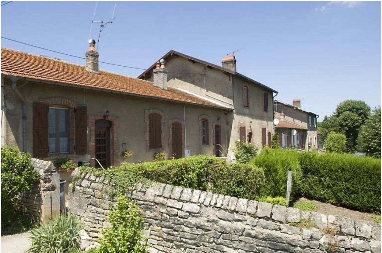
Logements ouvriers contigus. Vue depuis le sud-est.
