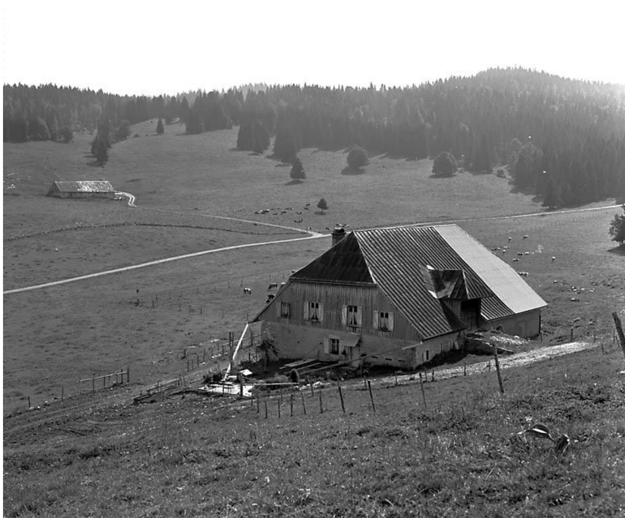
Ferme située au lieudit Bâtie Dessous : façade postérieure et latérale droite.
