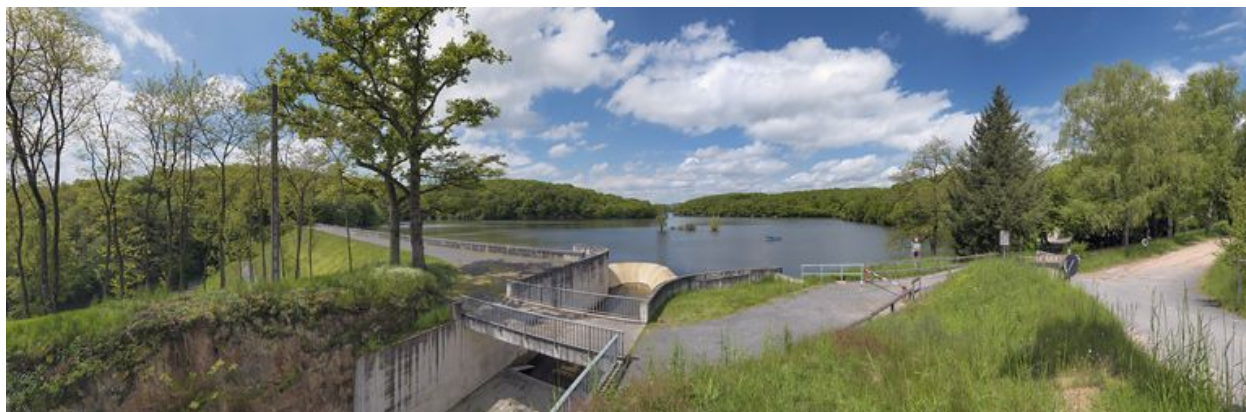
Vue d'ensemble du réservoir.
