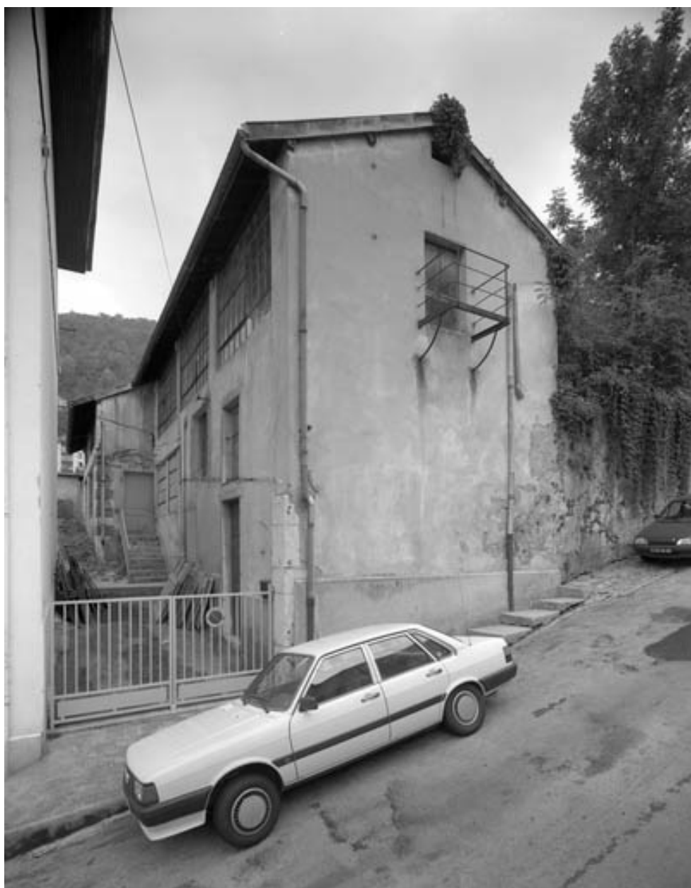
Entrepôts industriels (ancienne usine Genoud).
