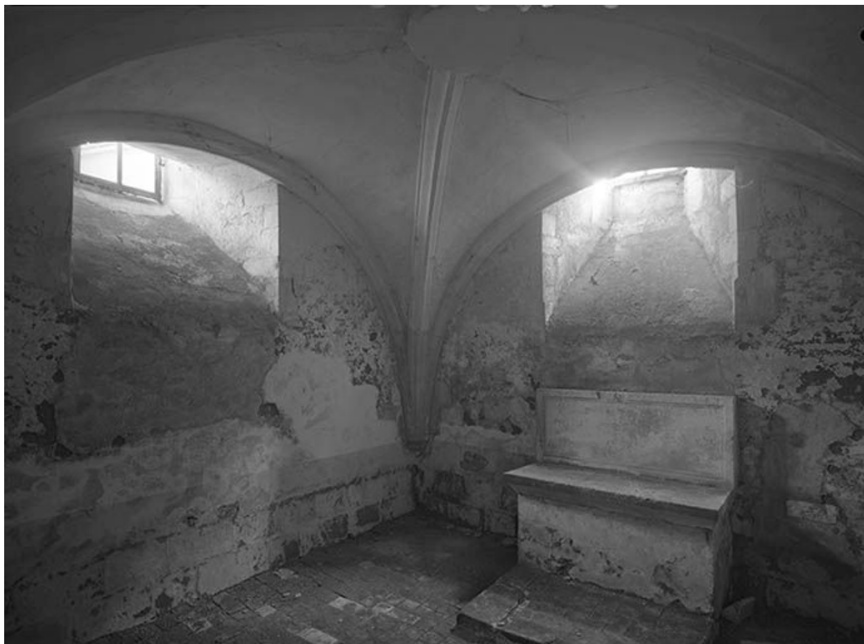
Crypte, vue depuis l'escalier.
