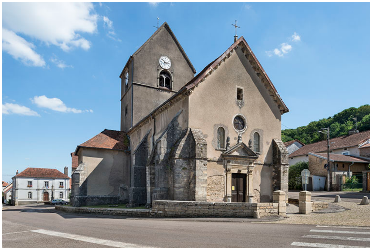
Vue avant restauration (2016).
