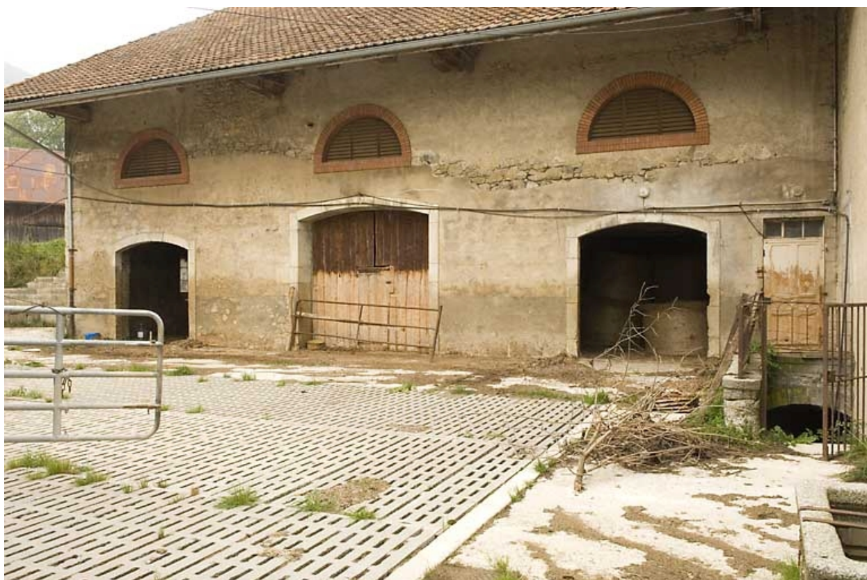
Etables et granges : façade latérale gauche.
