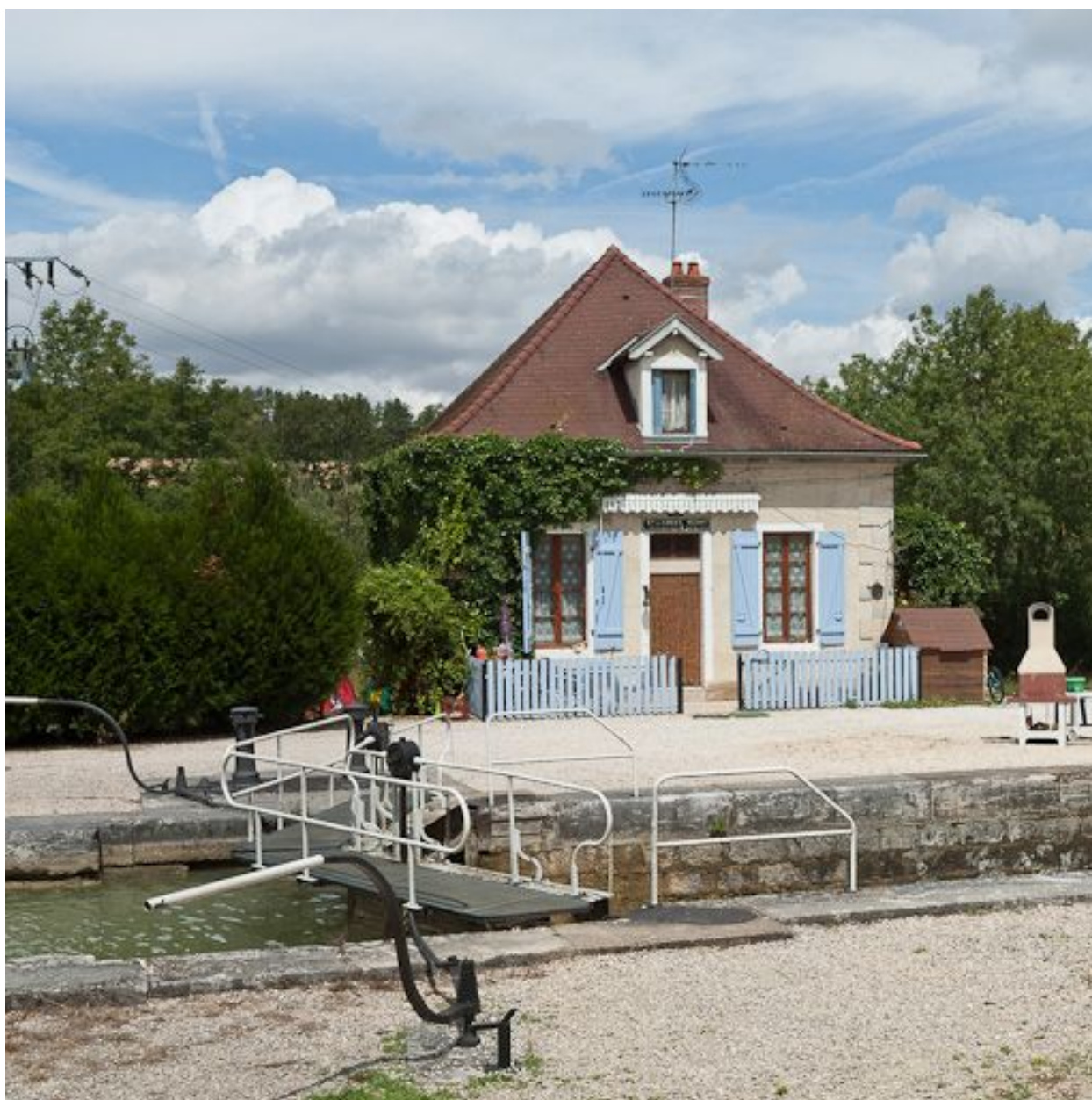
Vue de la maison éclusière.
