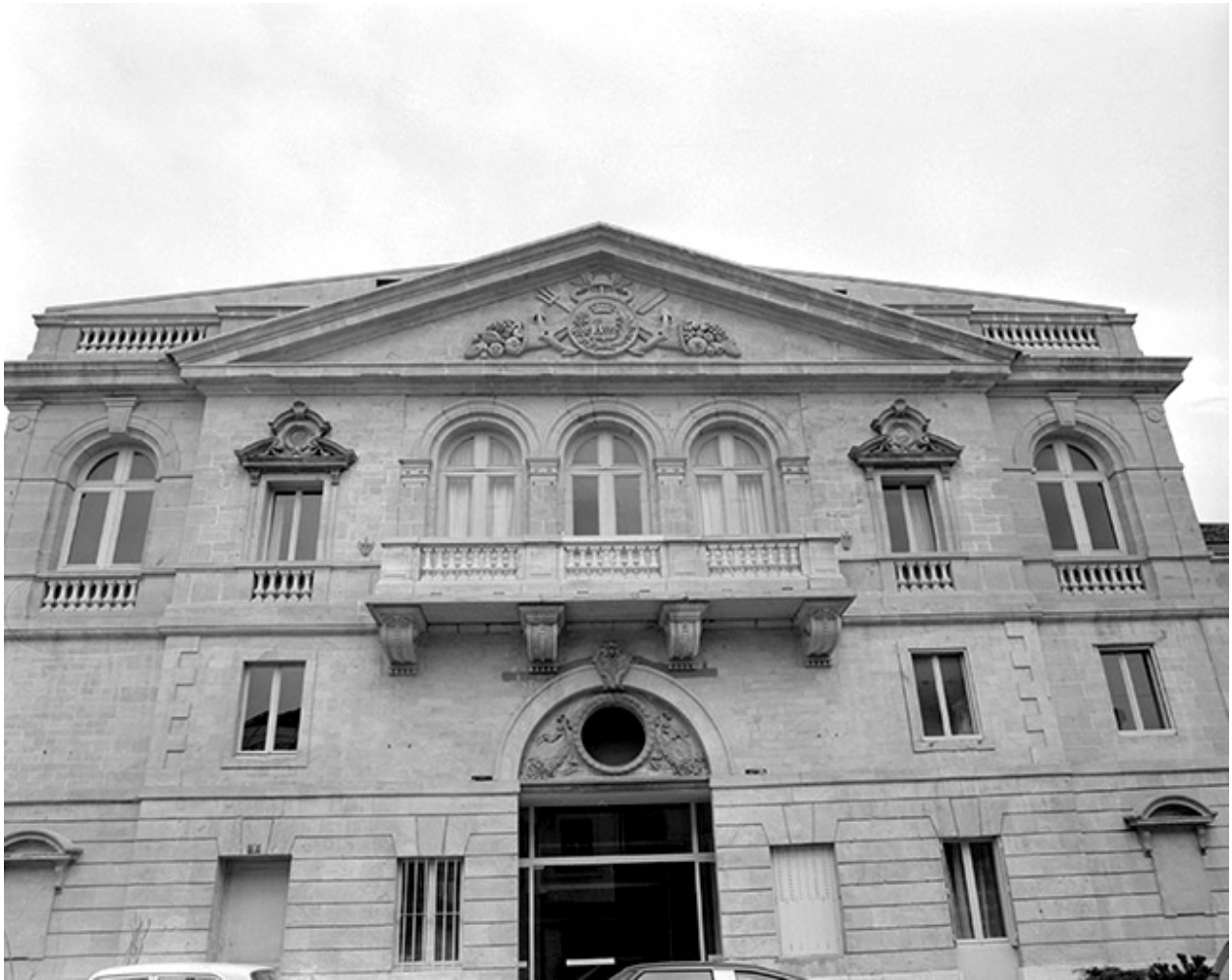
Façade antérieure. Corps central, vue d'ensemble.
