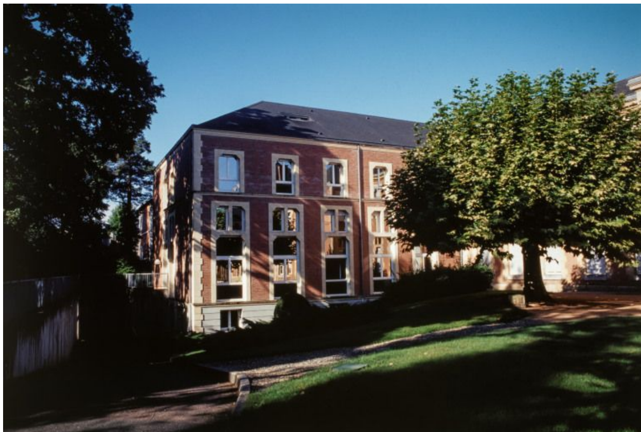
Façade postérieure, partie gauche.
