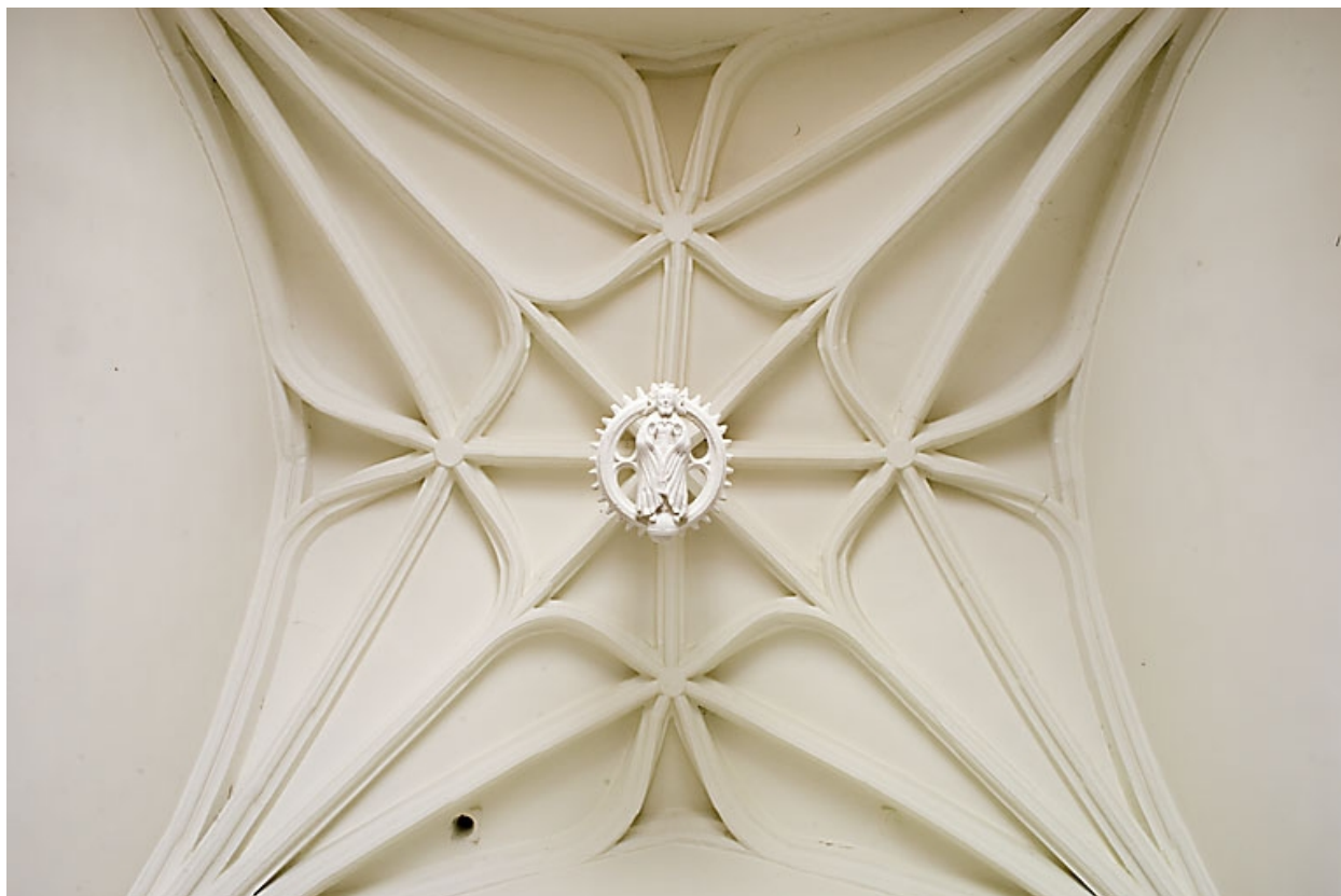
Voûte de la sacristie.
