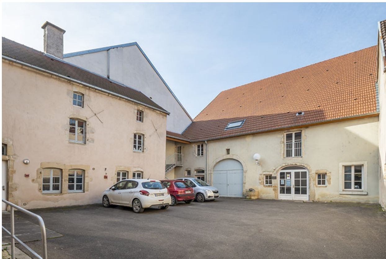
La cour, vue en direction du sud.
