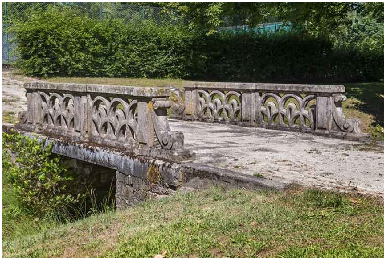
Pont à garde-corps en pierre.
