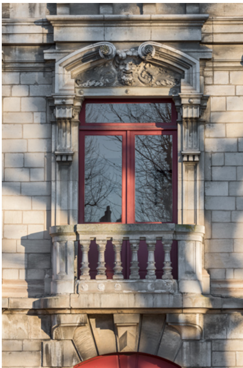
Façade latérale droite, étage carré : baie centrale.
