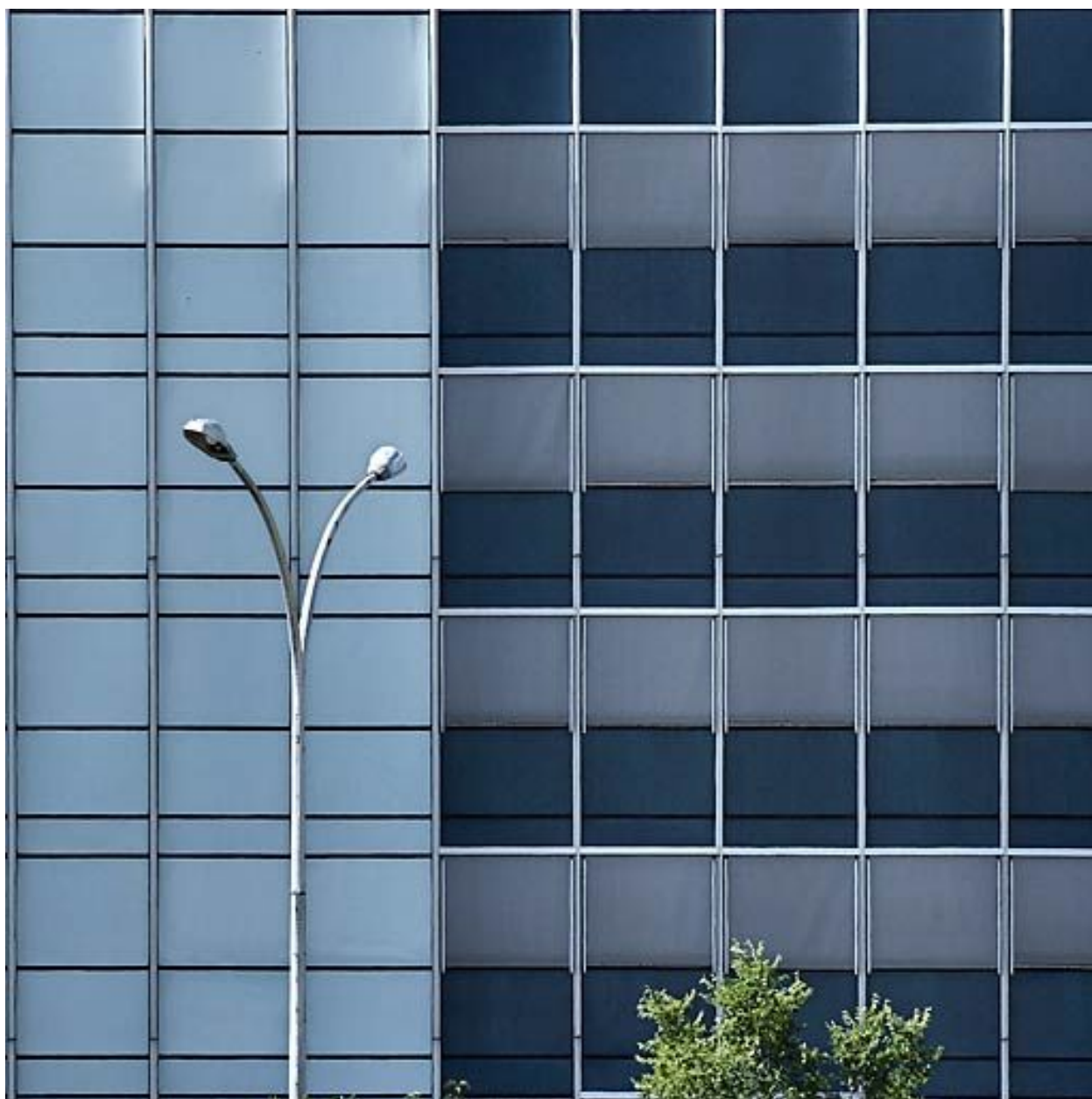
Bâtiment principal, détail.
