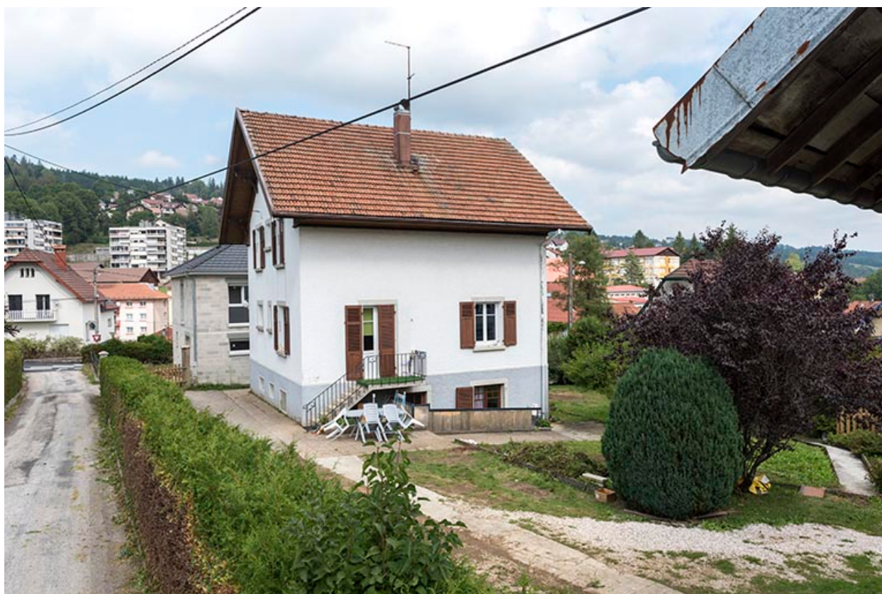
Maison : façades antérieure et latérale droite.
