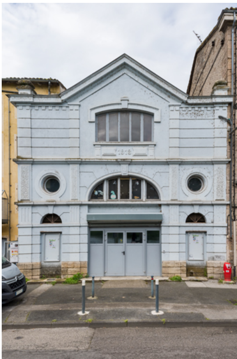
Façade postérieure, quai de Verdun.
